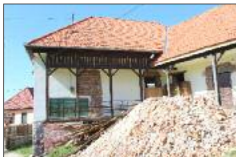
Hospiz in Malnas im Bau.
